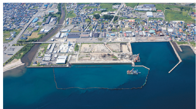
青森港油川地区（ふ頭用地造成事業）
