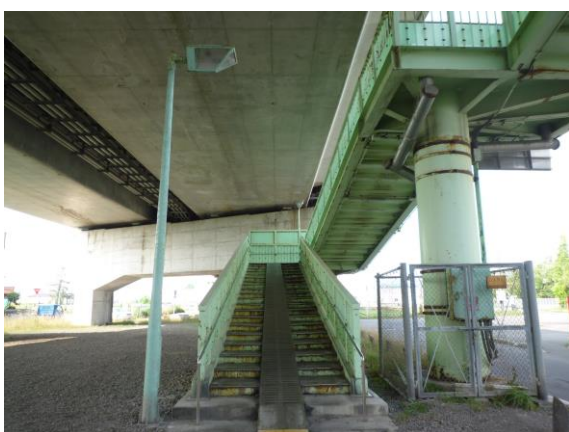
・ 着工前（歩道橋部分補修工事）
