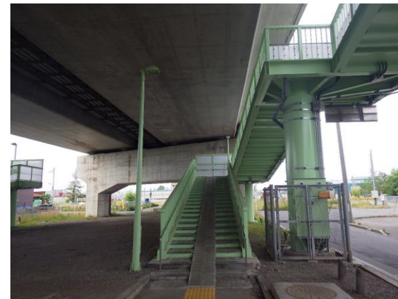
・ 完成（歩道橋部分補修工事）
