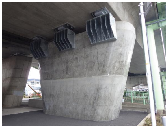
・ 完成（橋脚耐震補強工事）
