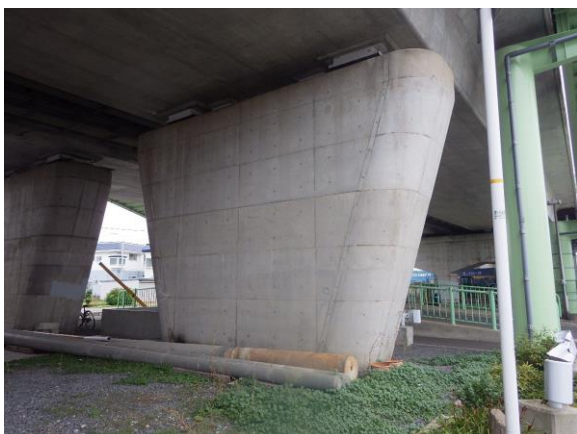
・ 着工前（橋脚耐震補強工事）
