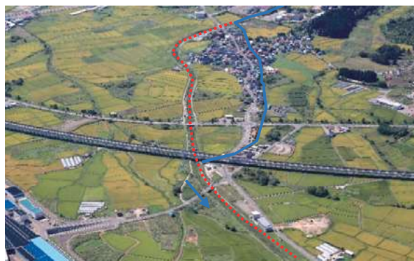
天田内川総合流域防災事業
