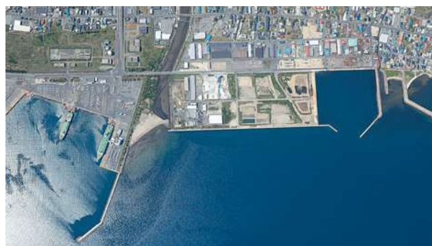
青森港油川地区（ふ頭用地造成事業）
