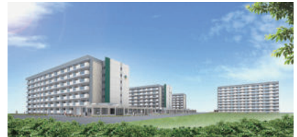
県営住宅小柳団地4号棟建設工事
