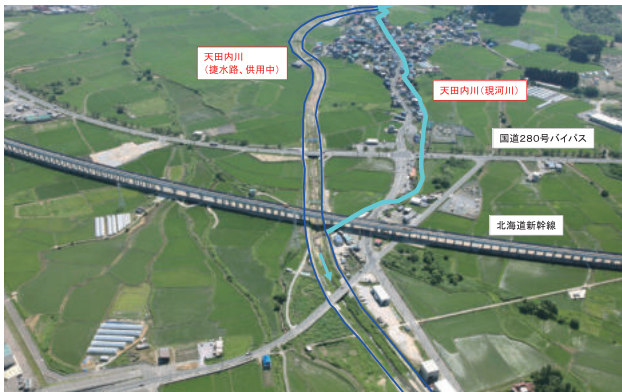
天田内川総合流域防災事業
