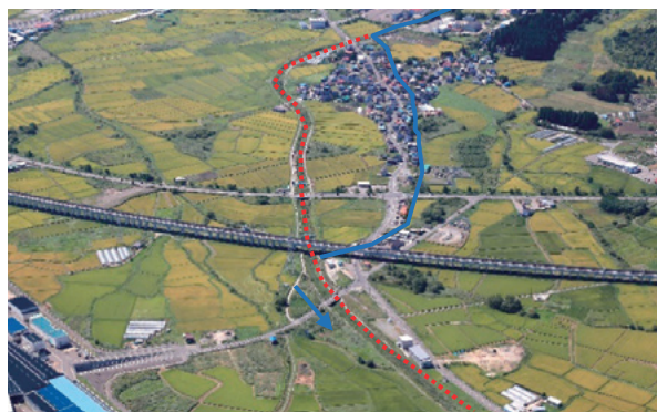
天田内川総合流域防災事業
