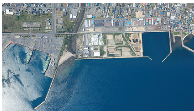
青森港油川地区（ふ頭用地造成事業）
