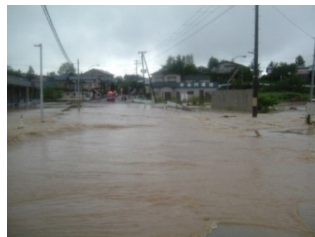
平成26年8月大雨冠水 （五所川原市川倉）
