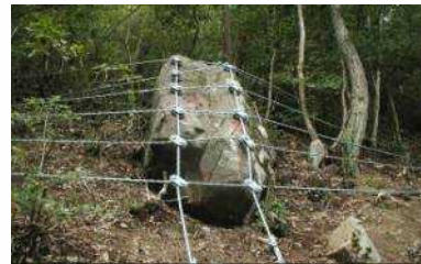
ロープ掛(写真)で固定 小割にして転石を除去
