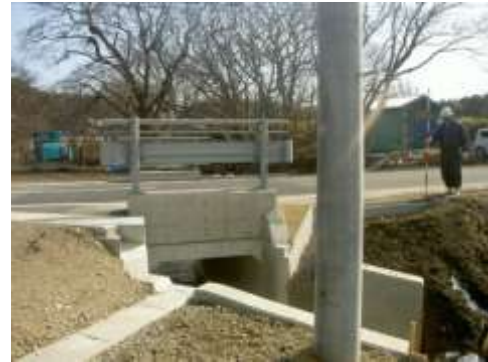
国道338号 たかはし橋【更新後】
