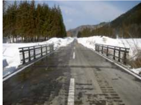
川内佐井線 目名橋【補修後】
