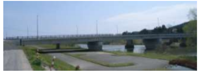
八戸三沢線 睦橋【更新後】
