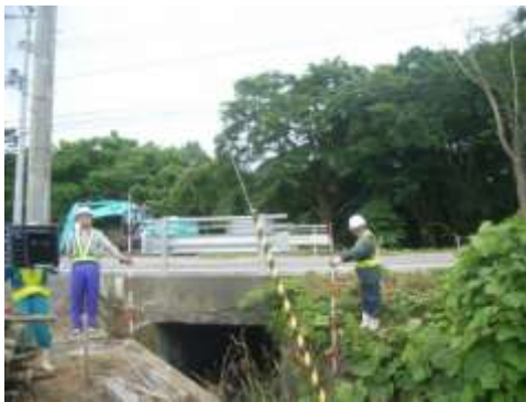
国道338号 たかはし橋【更新前】
