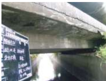
八戸三沢線 坪毛沢橋【補修前】
