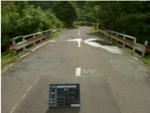
川内佐井線 目名橋【補修前】
