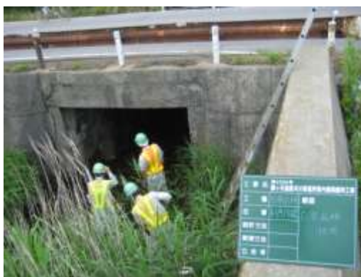
国道101号 赤石町1号橋（日常点検）
