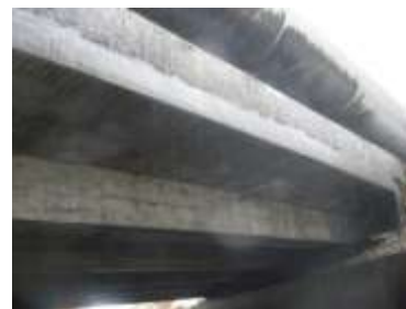
八戸三沢線 坪毛沢橋【補修後】
