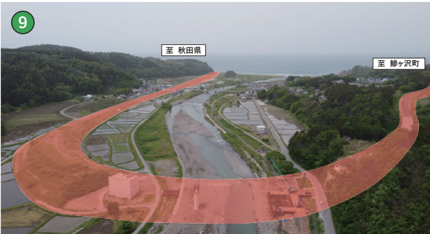
国道101号 追良瀬II期工区
