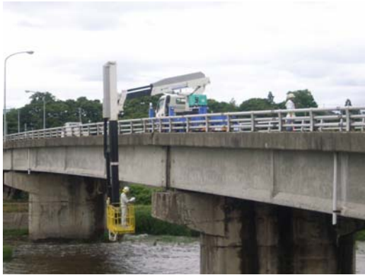
吹上金屋黒石線 浅瀬石橋
