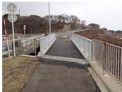
国道101号 新広戸橋側道橋【補修後】
