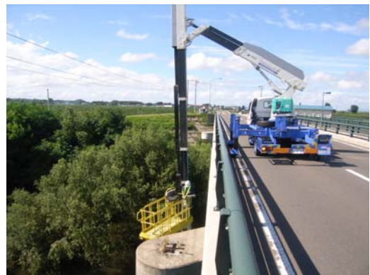
弘前柏線 三輪大橋
