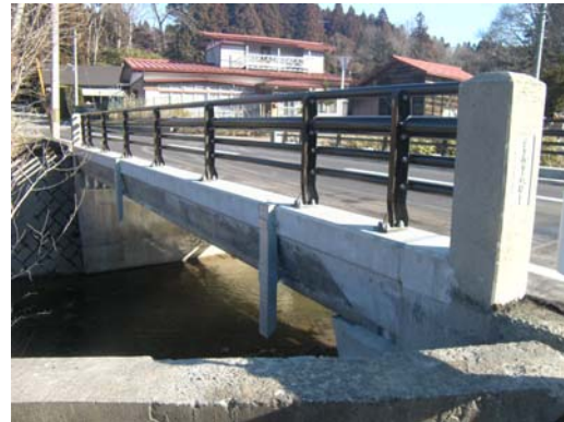
切田五戸線 万内橋【補修後】
