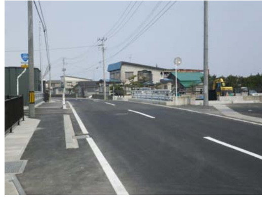
国道280号 浜田橋【更新後】
