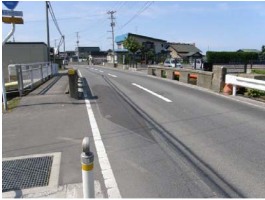
国道280号 浜田橋【更新前】
