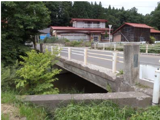
切田五戸線 万内橋【補修前】
