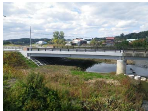
国道339号 於瀬道橋【施工後】
