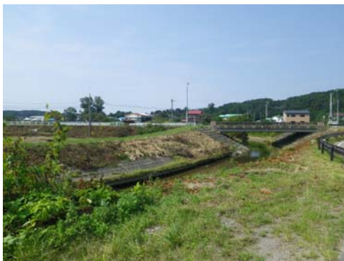
国道339号 於瀬道橋【施工前】
