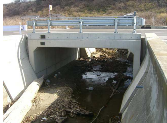
国道101号 尻無川橋【更新後】
