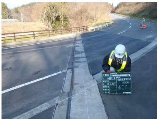
名川階上線 田代橋【補修前】
