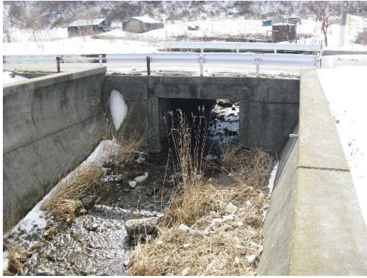
国道101号 尻無川橋【更新前】
