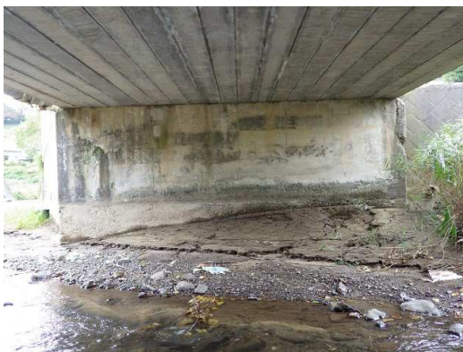
切田五戸線 万内橋【補修前】
