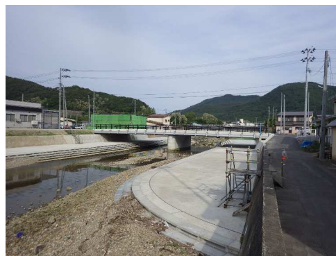
久栗坂造道線 根井橋【施工後】
