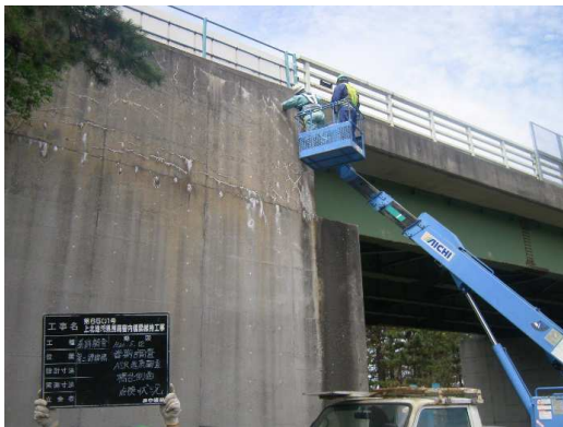
国道279号 第二跨線橋 （アルカリ骨材反応の追跡調査・春）
