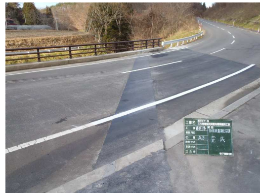
名川階上線 田代橋【補修後】
