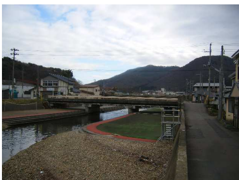
久栗坂造道線 根井橋【施工前】
