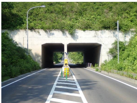
国道340号 泥障作2号カルバート
