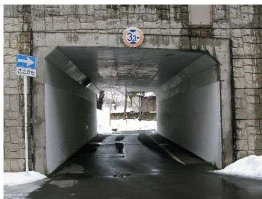
妙堂崎五所川原線 不魚住カルバート
