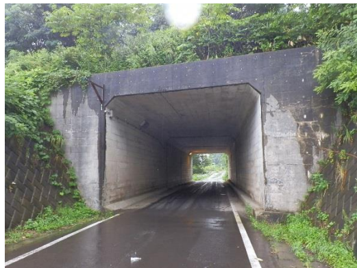
国道101号 前田野目2号カルバート
