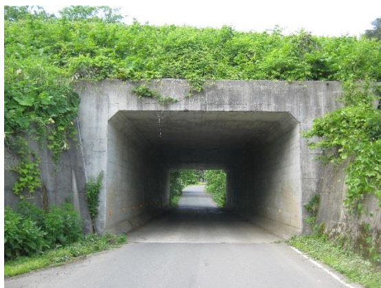
後平青森線 みちのく2号立体交差
