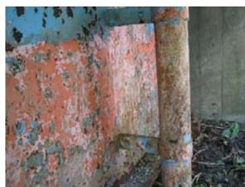
桁端部の腐食原因となり交換
