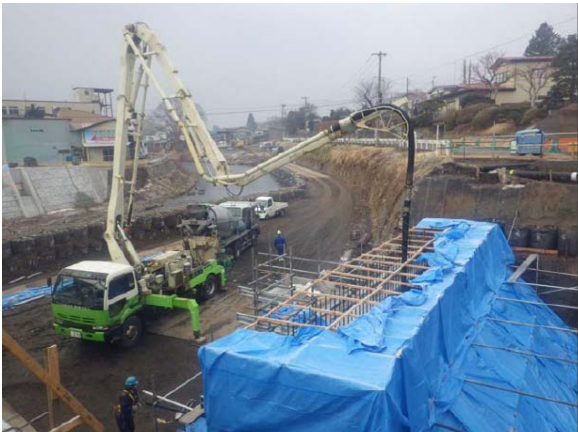
三戸南部線 黄金橋 A2 橋台コンクリート打設
