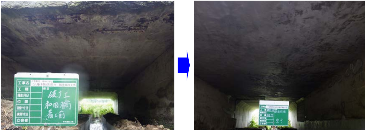
国道104号 和田橋 断面修復
