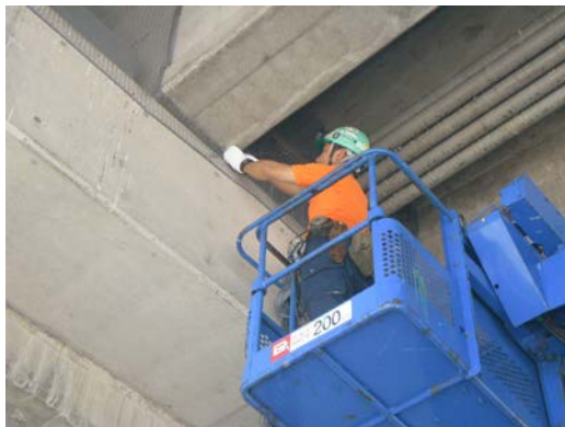
落下防止ネット設置
