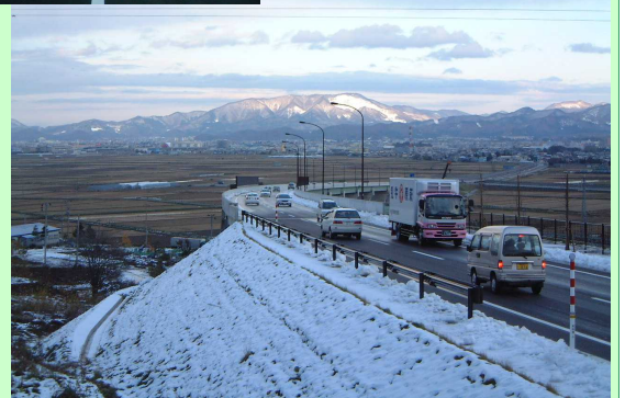
供用後の様子
