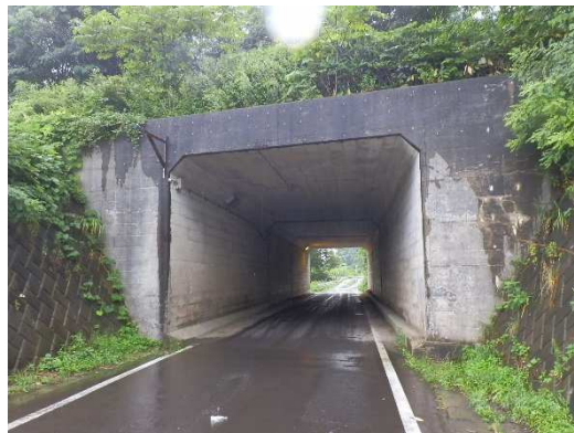
国道101号 前田野目2号カルバート
