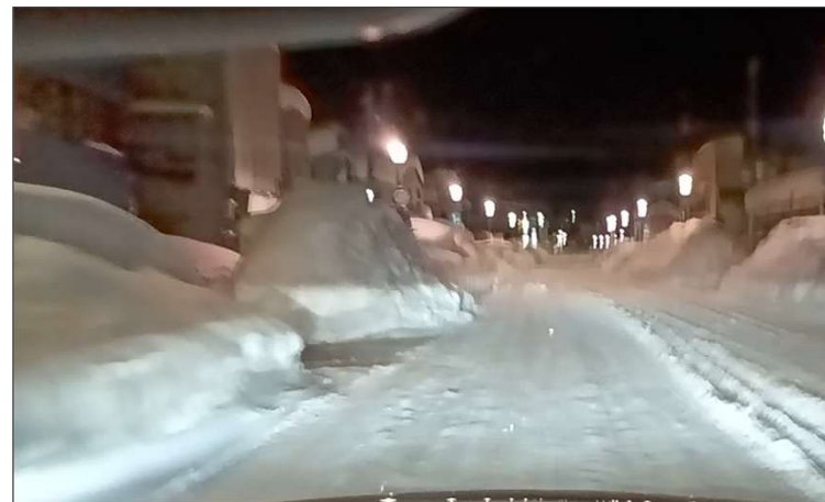
歩道と車道の境界部における堆積スペースの不足
