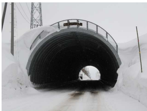
城ヶ倉スノーシェルター
