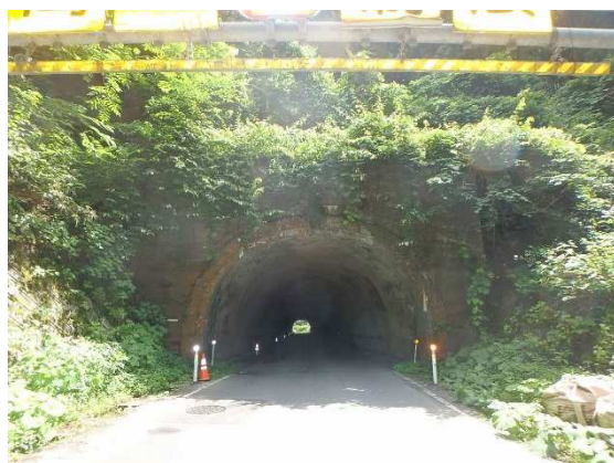
浅水南部線 手倉橋隧道
