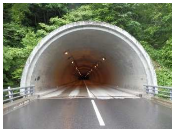
岩崎西目屋弘前線 寒沢トンネル
