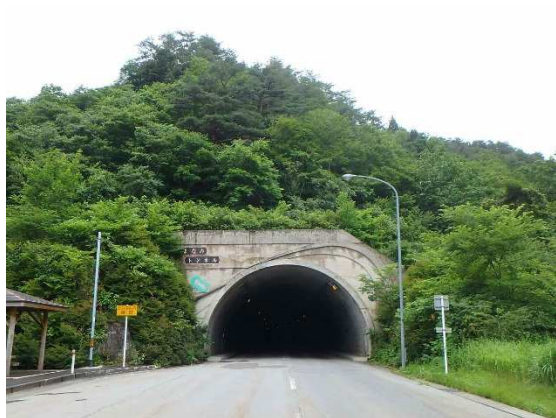
鱒ヶ沢蟹田線 やまなみトンネル
