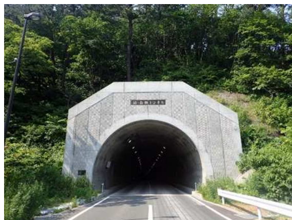
国道338号 泊・白糠トンネル
