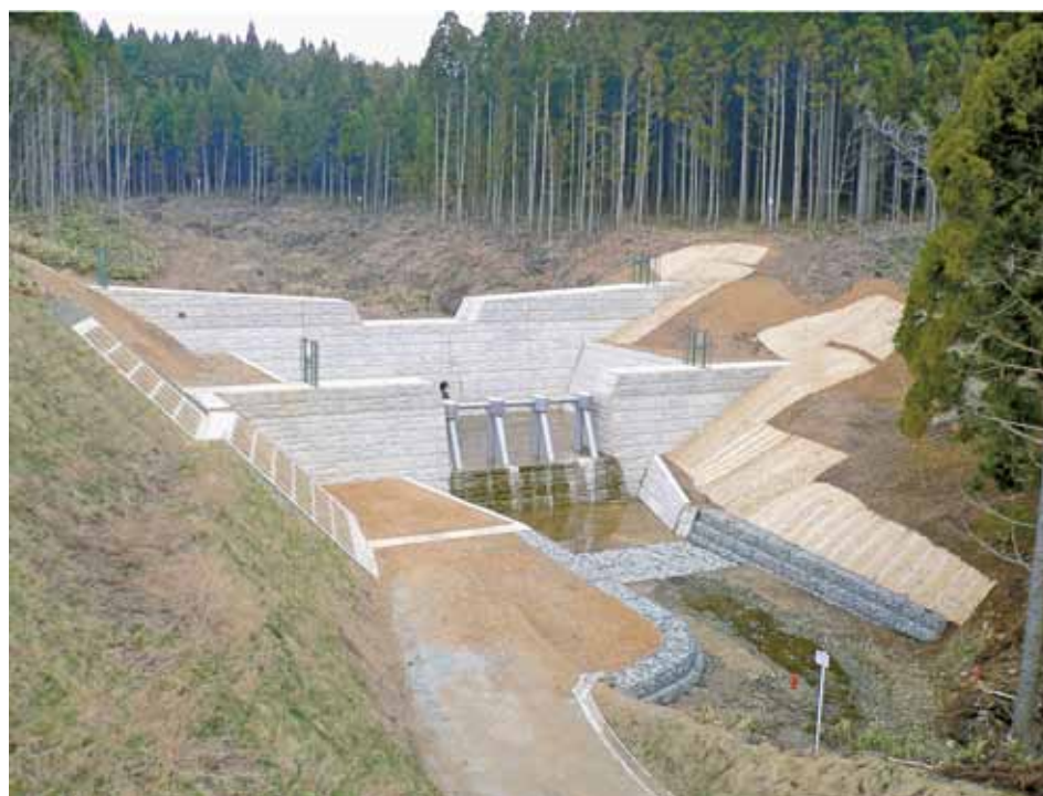
平成22年完成 吉花沢1号堰堤(深浦町)
