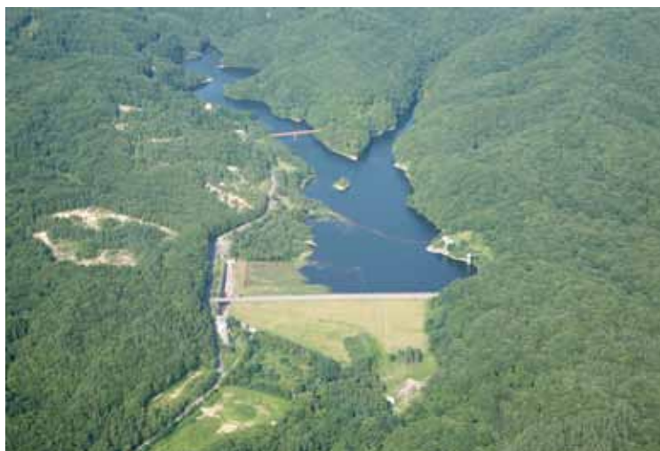
飯詰ダム（五所川原市）
