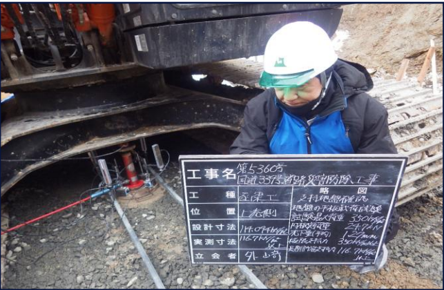
平板載荷試験による支持力確認
