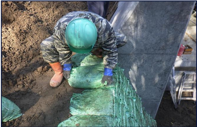
植生土のう設置
