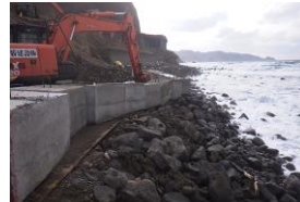
現場施工箇所への 高波・高潮対策
