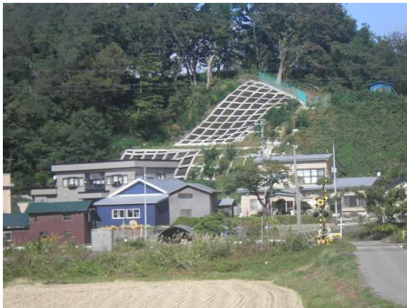
令和4年度施工完成（全景）
