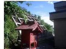
③ 元々の場所に再移設 (法面施工後)
