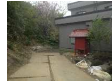
② 仮移転(法面工事中)
