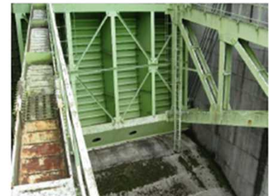
放流設備の改修(塗装、水密ゴム交換)
