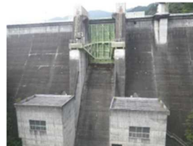
放流設備の改修(塗装、水密ゴム交換)
