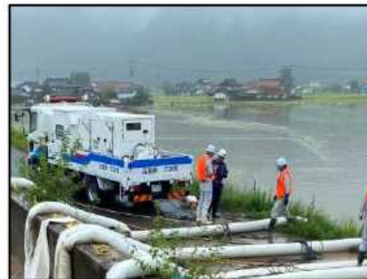
排水施設の整備
