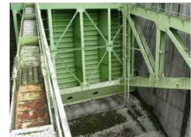
放流設備の改修(塗装、水密ゴム交換)
