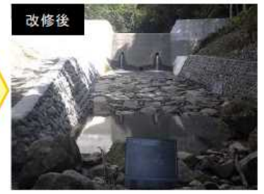
砂防における老朽化した施設(堰堤)の改修
