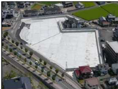
雨水貯留浸透施設の整備、改良
