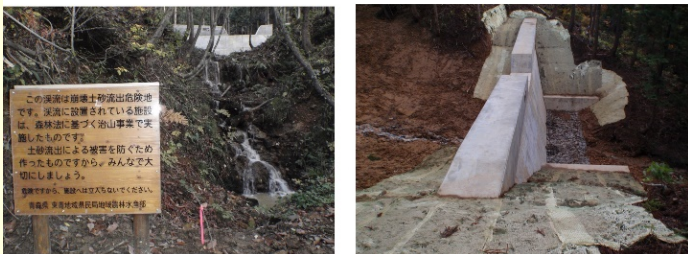
既設治山ダム（コンクリート）
