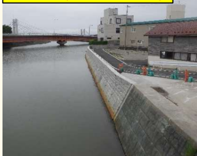
復旧完了（明海橋下流右岸）
