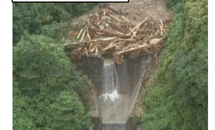
土砂・流木の捕捉事例
