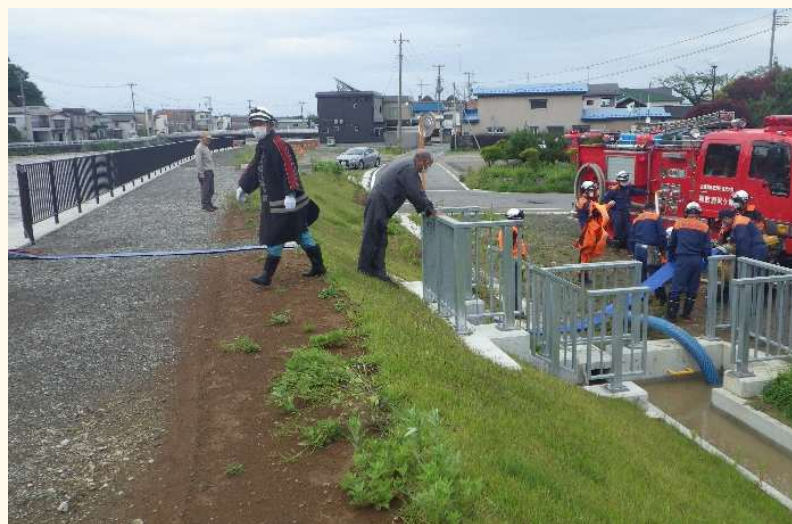
可搬式ポンプによる排水状況
