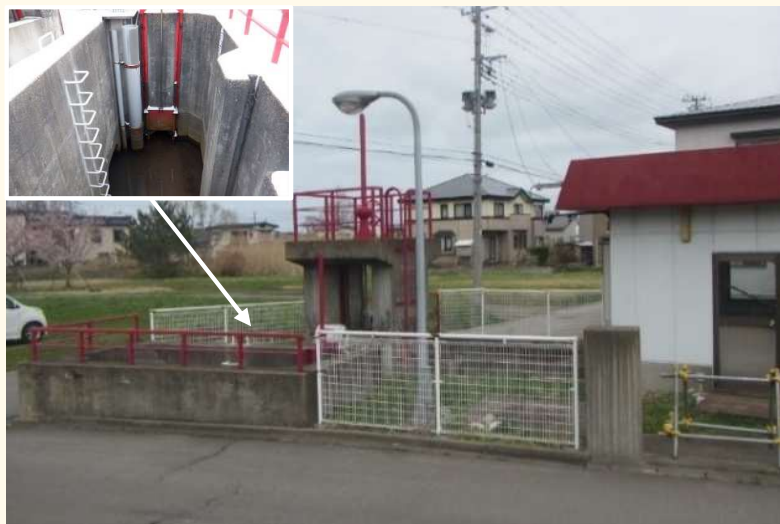
既存の排水機場
