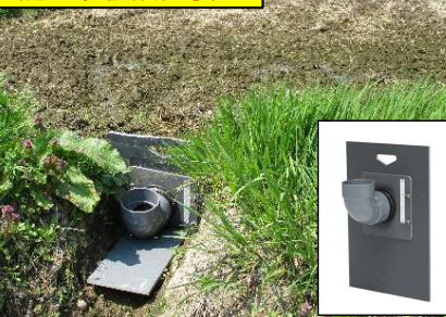
調整堰板設置状況
