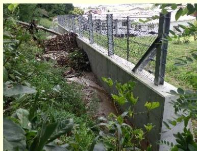
崩落土砂を捕捉
