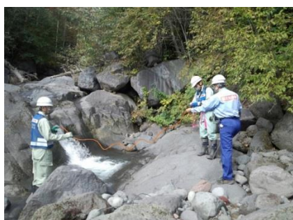
左：2014年御嶽山（長野県、岐阜県）噴火直後のワイヤーセンサ緊急設置状況（国土交通省中部地方整備局 HP） 右：2011年霧島山新燃岳（宮崎県、鹿児島県）噴火時に仮設された簡易避難壕（アジア航測株式会社 提供）
