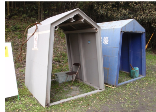
(2011年霧島山新燃岳噴火時に仮設された簡易避難壕)
