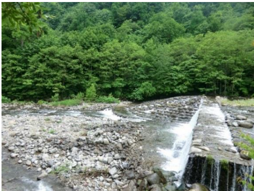
改良された魚道
