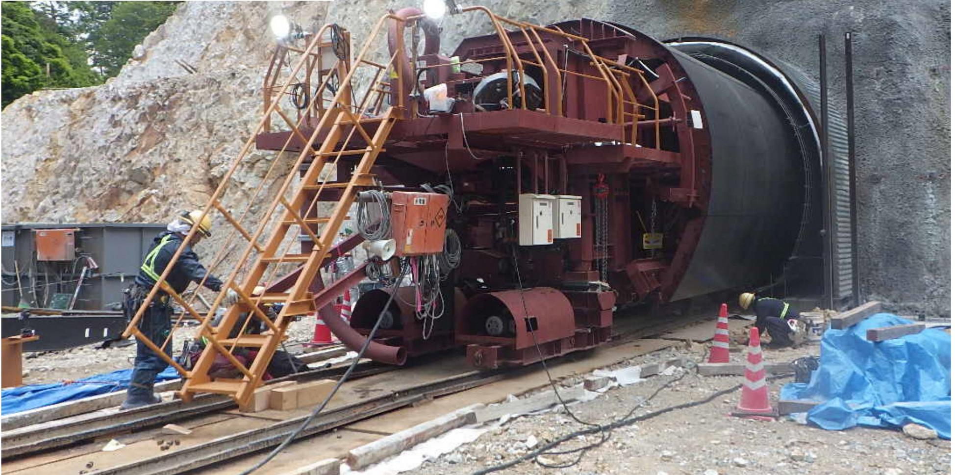
(5) セントル（覆工コンクリート打設用設備）進入状況（R5年6月撮影）
