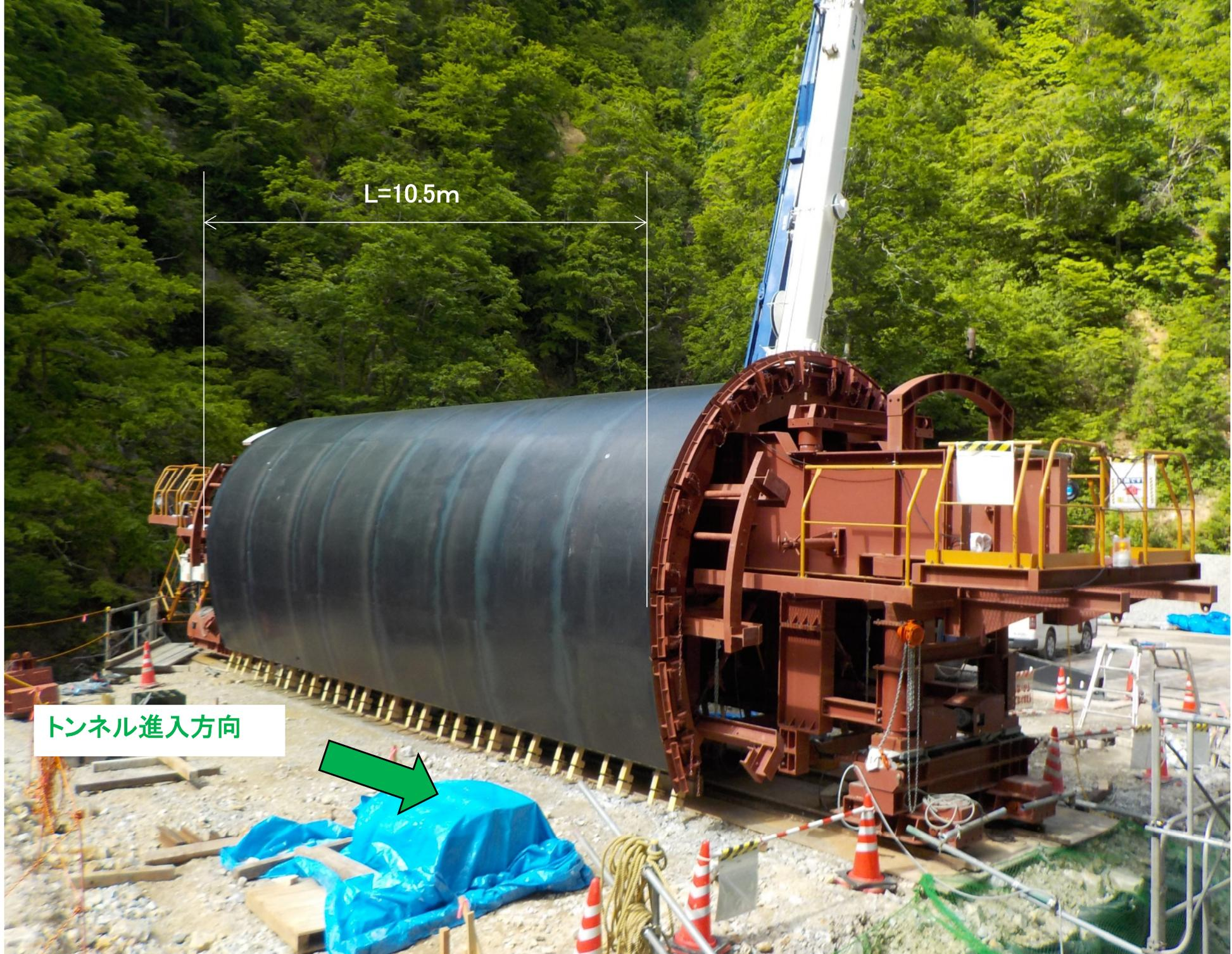
(4) セントル（覆工コンクリート打設用設備）組立完了状況（R5年5月撮影）
