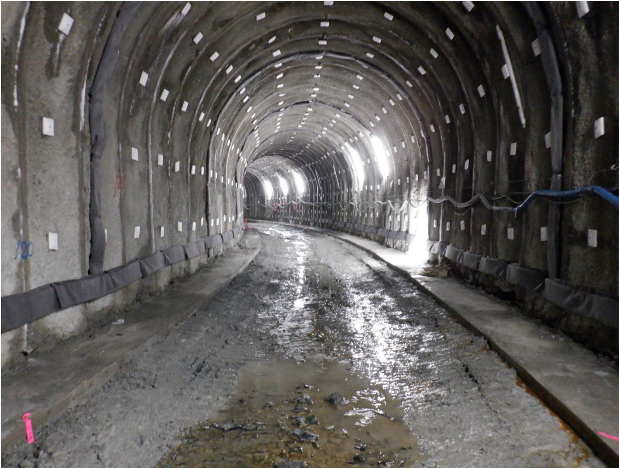
(2)堤外仮排水トンネル 掘削完了状況 (R5年6月撮影)
