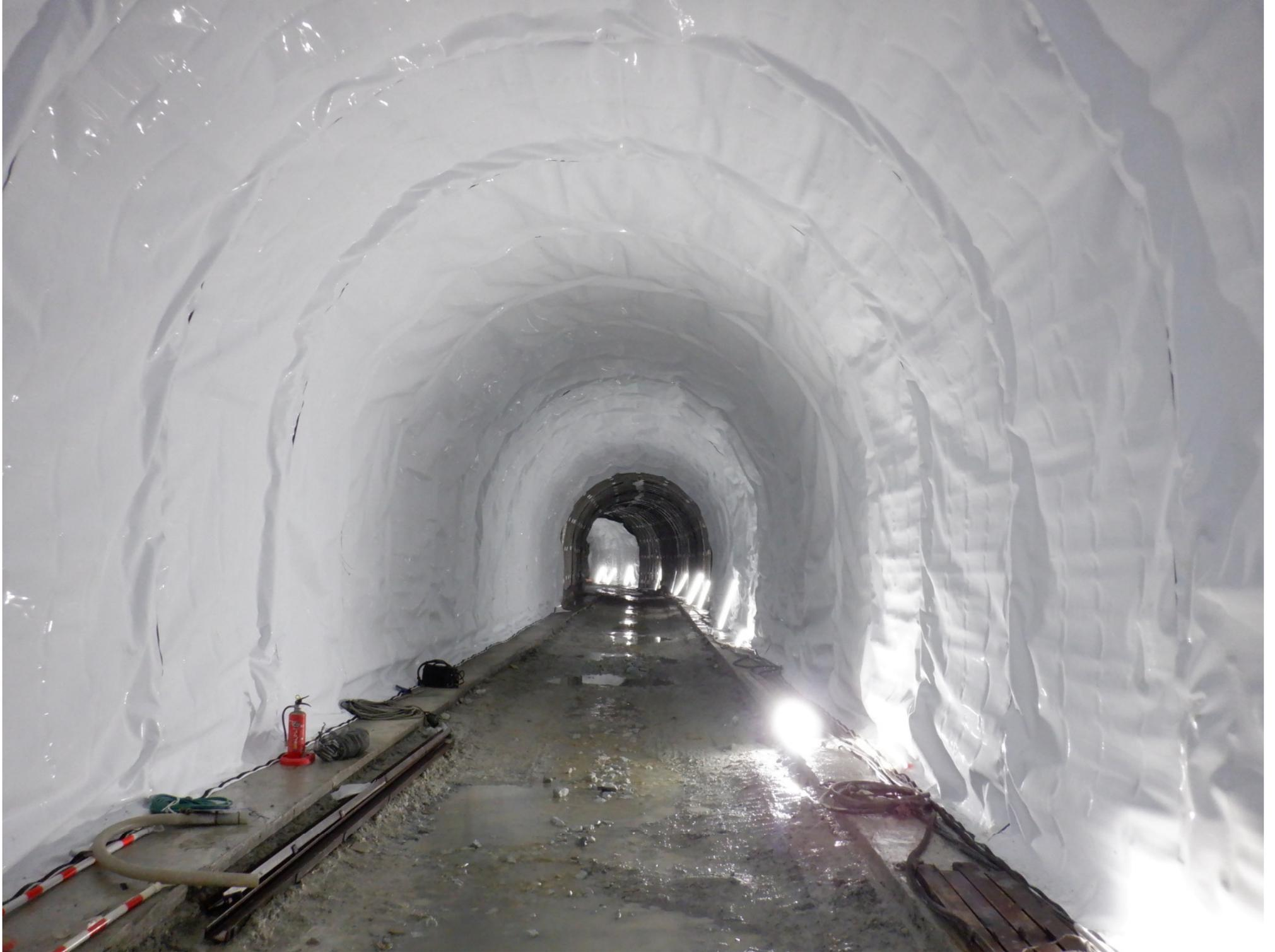
(3)堤外仮排水トンネル 覆工コンクリート打設前状況 (R5年6月撮影)
