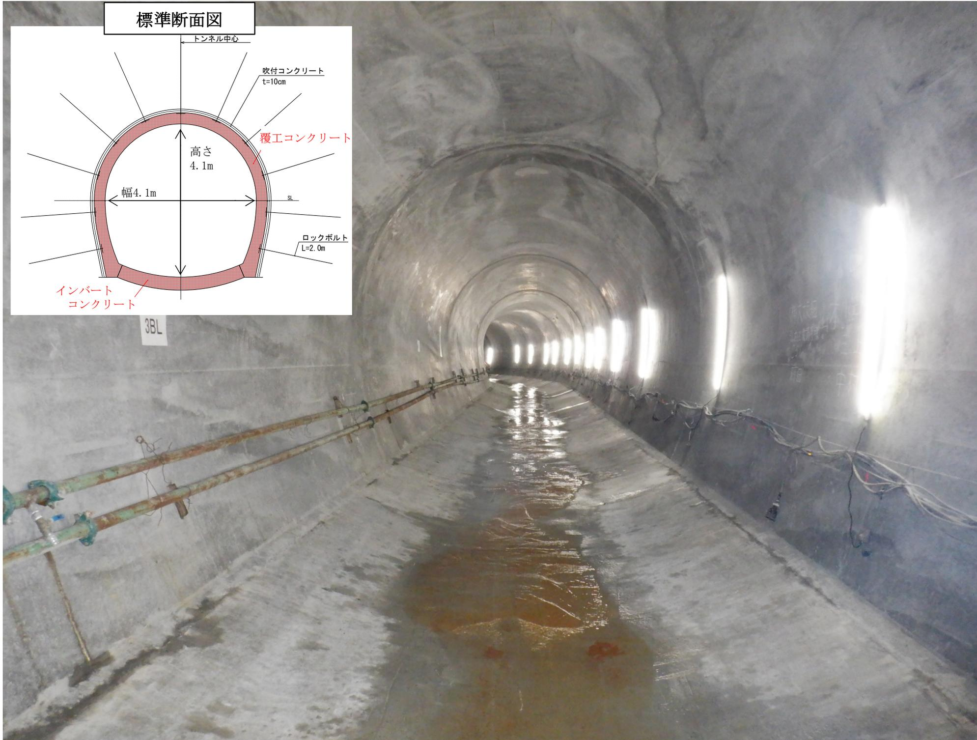
(6)堤外仮排水トンネル 覆工コンクリート完了状況 (R5年11月撮影)
