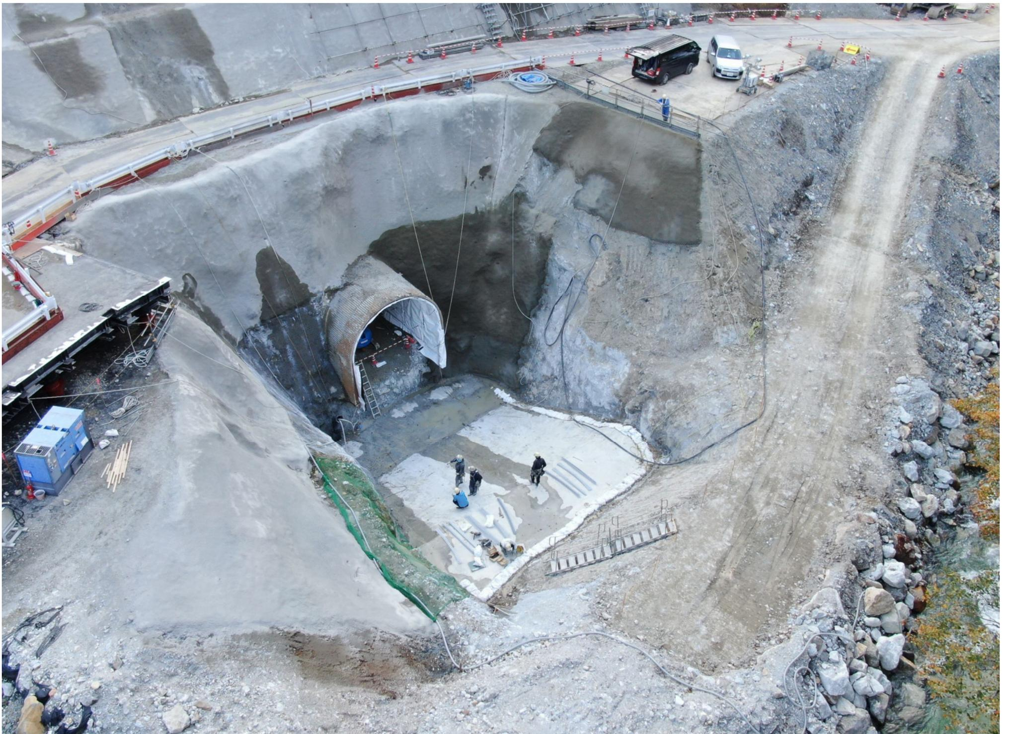
(8)堤外仮排水トンネル呑口部施工状況 (R5年10月撮影)
