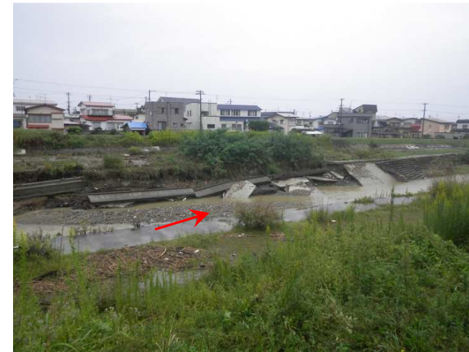
大和沢川(弘前市)
