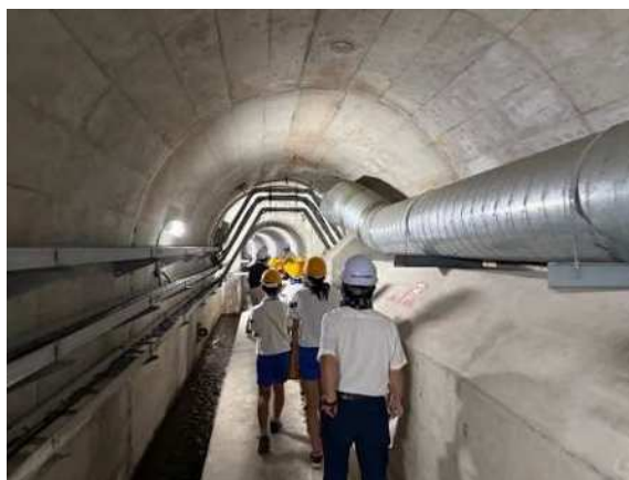
ダム見学（下湯ダム：監査廊）
