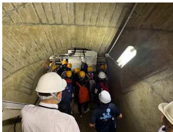
ダム見学（世増ダム：監査廊）
