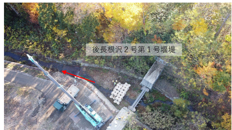
仮設堰堤工造成状況（コンクリートブロック据付完了）
