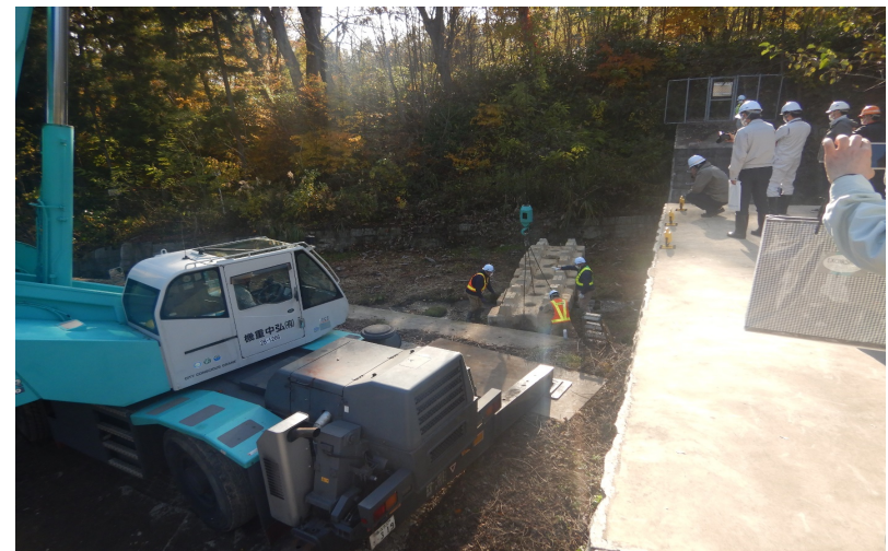
仮設堰堤工造成状況（コンクリートブロック据付作業）
