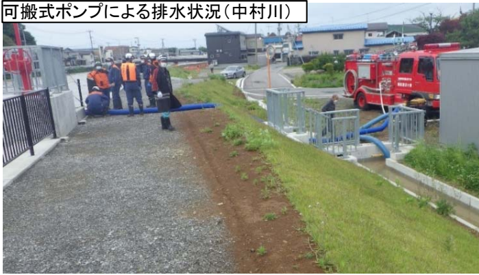
中村川排水機場
