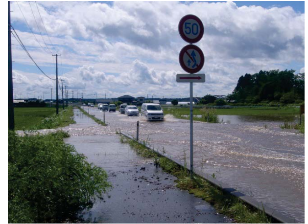
赤川(東北町) 八戸野辺地線冠水状況
