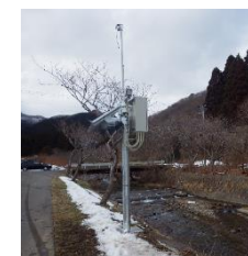
河川監視用カメラ
