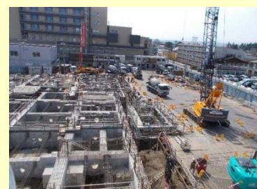
新庁舎建設風景 H30.4.30撮影
