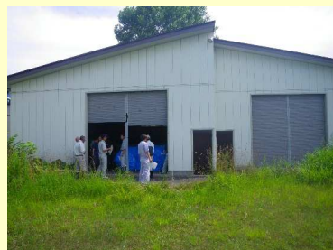
県水防倉庫巡視 H29.7.26撮影
