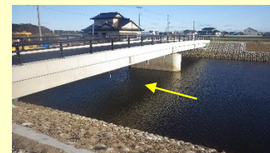
【明神川】沼端1号橋
