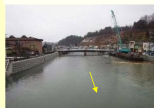
【中村川】舞戸橋付近(R2.1施工状況)
