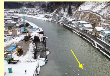
【中村川】舞戸橋付近（R3.2施工状況）
