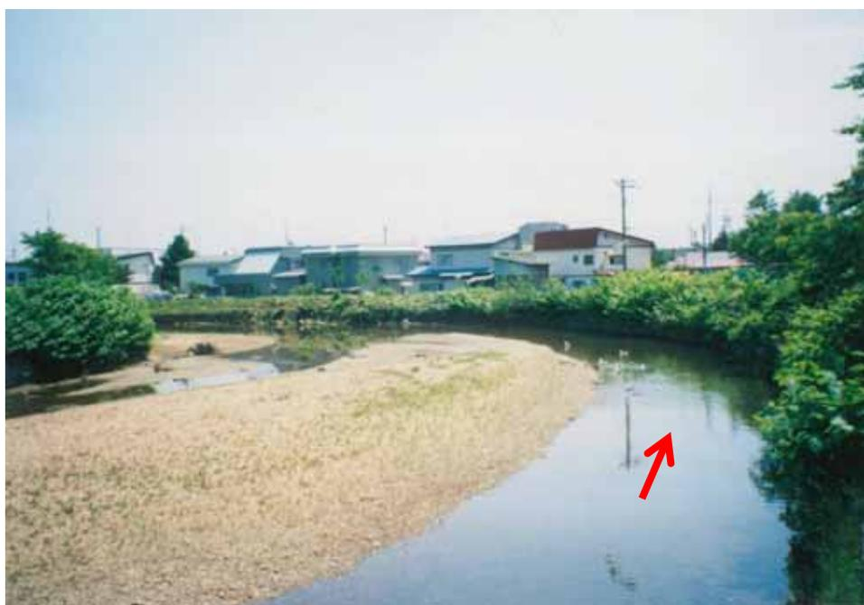
写真 1-5 土砂堆積の様子
