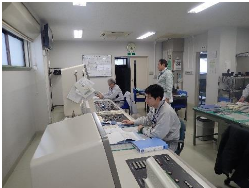
青森空港での航空灯火監視状況
