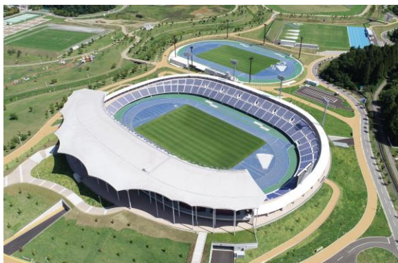
新青森県総合運動公園陸上競技場（平成30年竣工）
