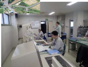
青森空港での航空灯火監視状況
