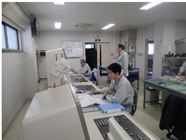
●青森空港での航空灯火監視状況
