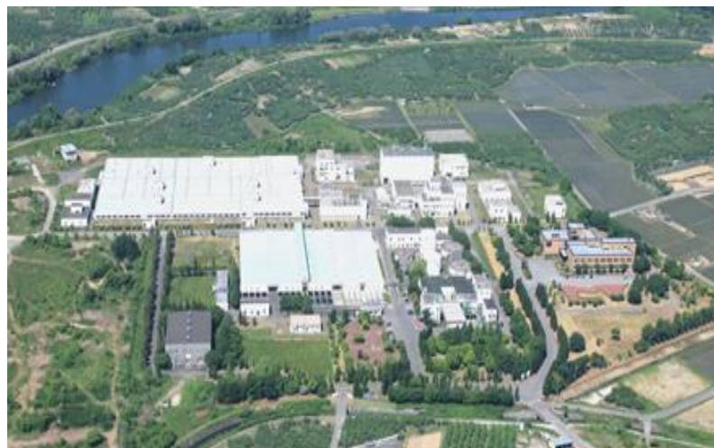
●岩木川浄化センター（昭和62年供用開始）
