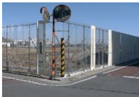
工事中の仮囲いにおける見通しの確保
