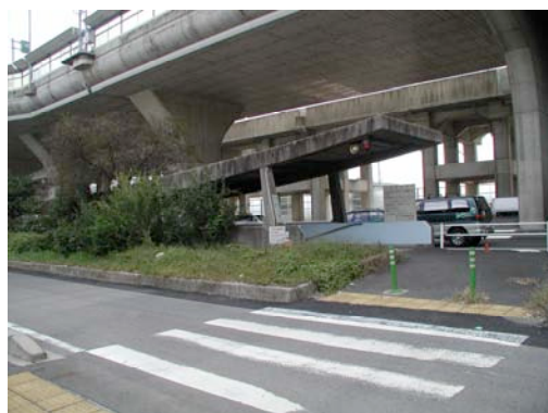
地下横断歩道の出入口における赤色回転灯の設置事例
