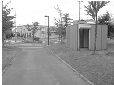
公園の出入口に設置した公衆便所の例
